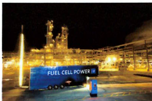
Figura 11 - Célula a Combustível ( Fuel Cell ) a hidrogênio da GM fornecendo eletricidade para a fábrica da Dow Chemical no Texas, EUA
