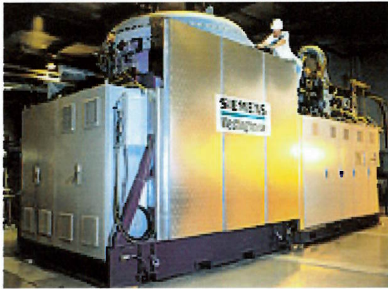
Figura 25 - 220-kW SOFC integrada com microturbina a gás, instalada na Universidade da Califórnia
